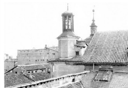
Vista de las cubiertas de la iglesia
